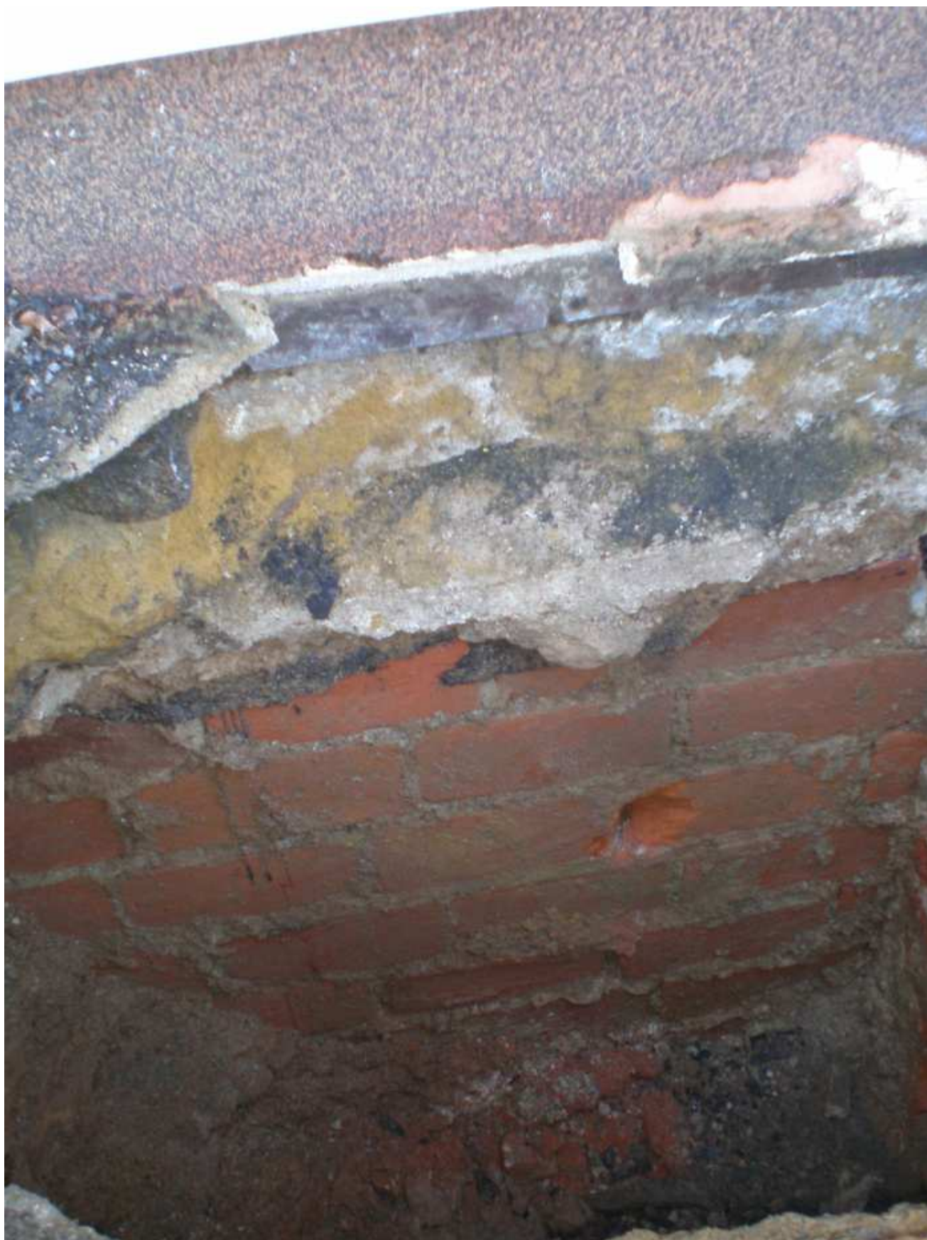
CIHELNÁ PŘIZDÍVKA STÁVAJÍCÍ SVISLÉ HYDROIZOLACE
