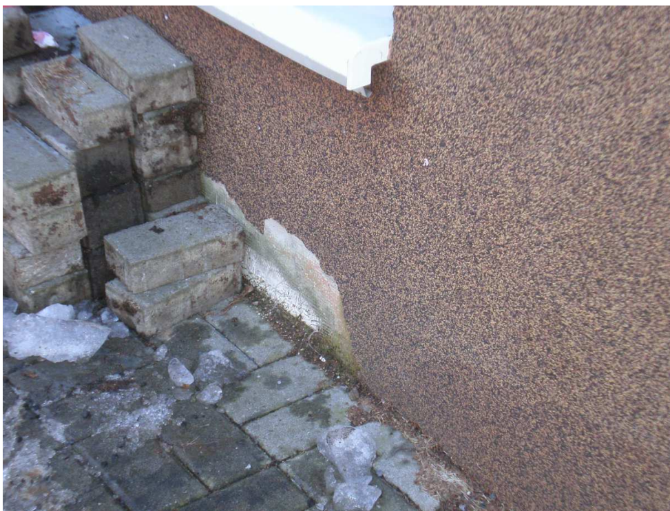
STAV DLÁŽDĚNÉHO OKAPOVÉHO CHODNÍČKU A POVRCHOVÉ ÚPRAVY SOKLU ŠKOLY
