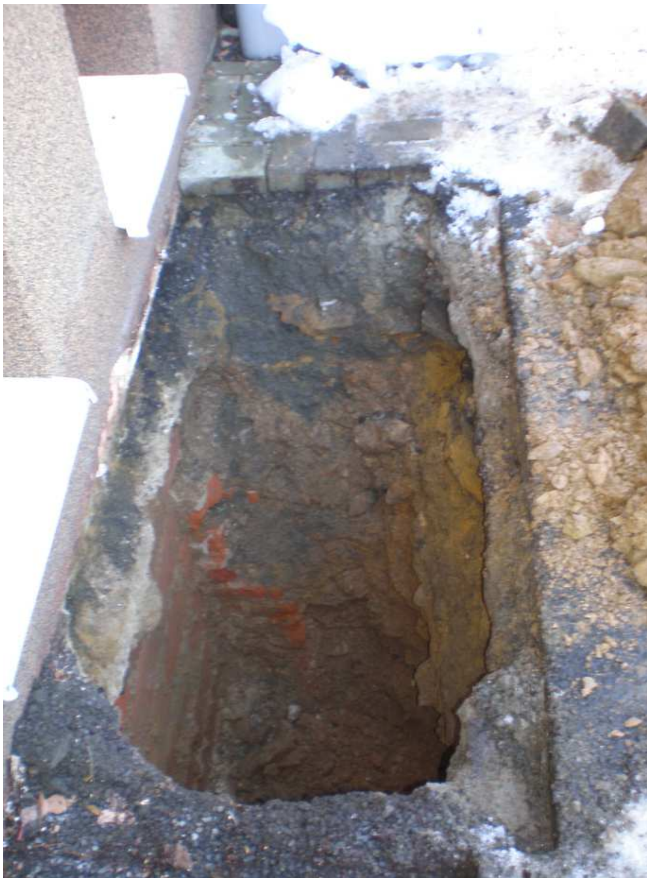
KOPANÁ SONDA – PILÍŘEK CIHELNÉ PŘIZDÍVKY
