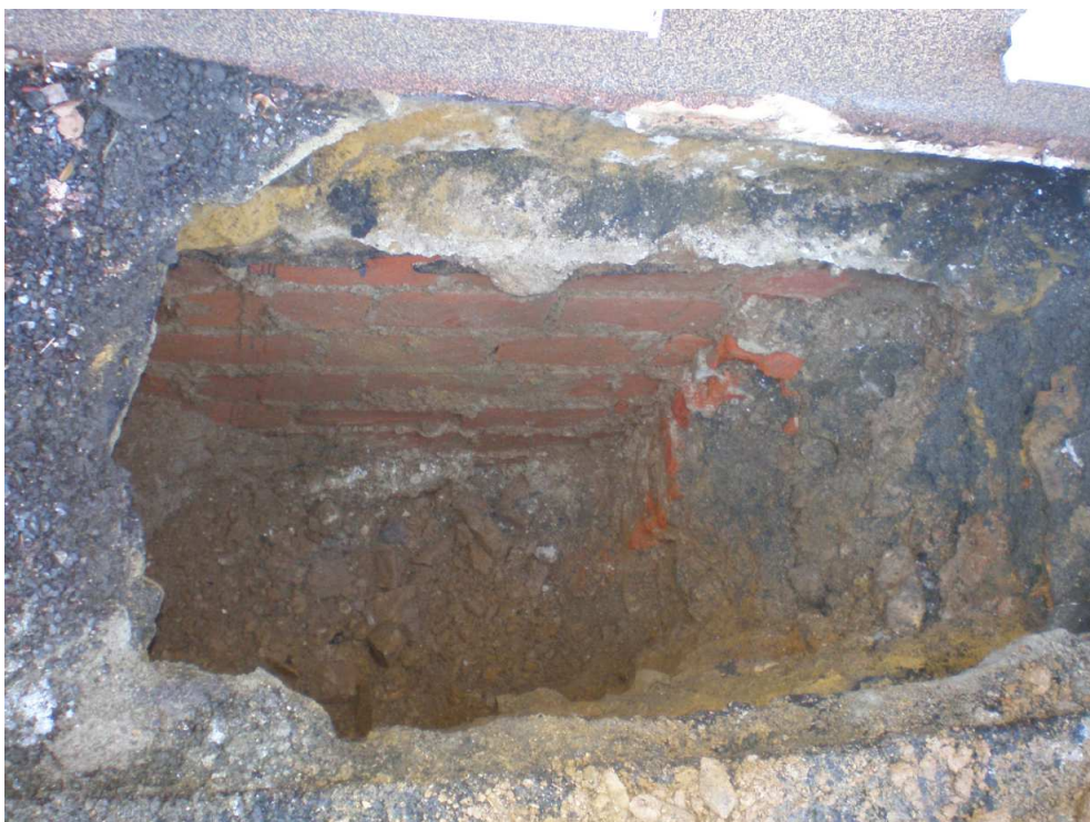
CIHELNÁ PŘIZDÍVKA (HYDROIZOLACE NEBYLA ODKRYTA)
